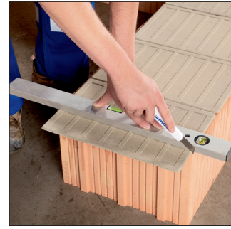
maxit mörtelpads bei Bedarf zuschneiden
