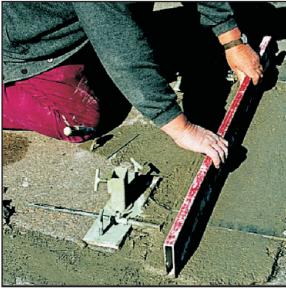
Wie beim normalen Planziegel-Mauern wird die erste Schicht maßgenau in Zementmörtel M10 versetzt.
