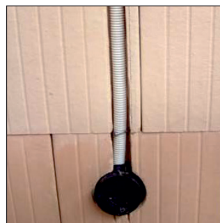
Einlegen der Elektroinstallation in die Schlitzte.
