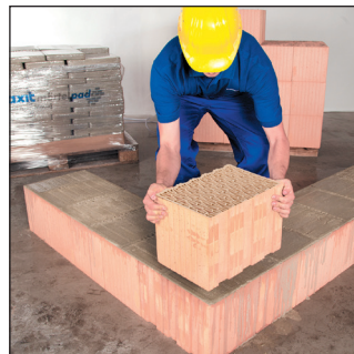
Mauerstein vollflächig auflegen
