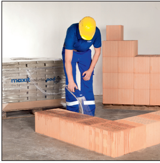
Mauersteine befeuchten
