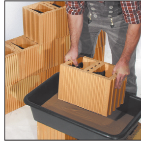
Der im Eimer angerührte Dünnbettmörtel wird in die Mörtelwanne gefüllt. Hier wird Ziegel für Ziegel kurz eingetaucht, der Mörtel haftet sofort fest an der Ziegelunterseite.
