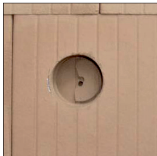
Evtl. Ziegelreste und Bohrmehl entfernen - fertig ist ein perfektes Loch für eine Elektrodose.
