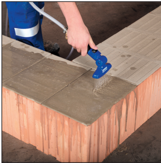
maxit Mörtelpads befeuchten
