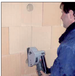
Schlitzten der Ziegel mit der Schlitzfräse.
