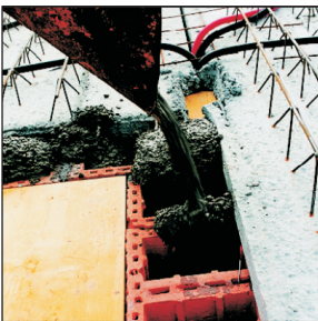
Die Befüllung des Planfüllziegels wird mit Beton C12/15 (Körnung 0-16, mit BV) durchgeführt. Danach kann die Decke betoniert werden.
