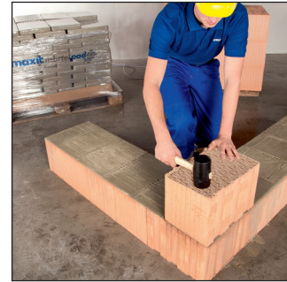
Mauerstein wie gewohnt ausrichten. Fertig!
