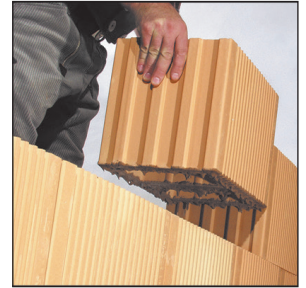
Nachdem die erste Schicht auf Mörtel versetzt ist, wird noch nicht verfüllt, sondern mit Dünnbettmörtel die Wand in ihrer gesamten Höhe erstellt.
