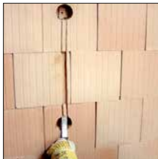
Vorgesägte Schlitzte mit Hammer und Meißel freischlagen.
