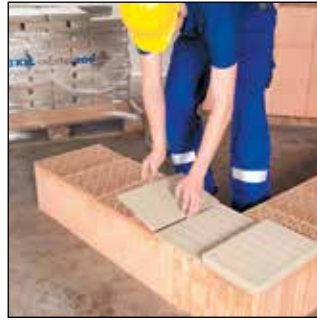
maxit mörtelpads auflegen
