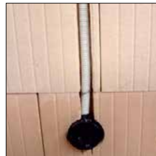
Einlegen der Elektroinstallation in die Schlitzte.
