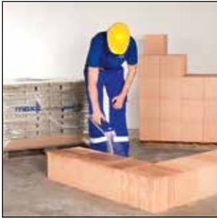
Mauersteine befeuchten
