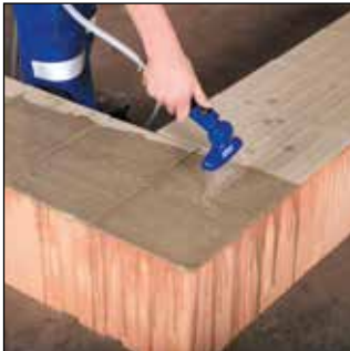
maxit Mörtelpads befeuchten
