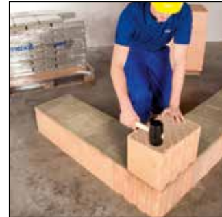
Mauerstein wie gewohnt ausrichten. Fertig!
