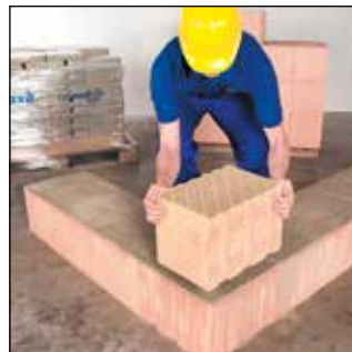
Mauerstein vollflächig auflegen
