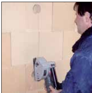
Schlitzten der Ziegel mit der Schlitzfräse.
