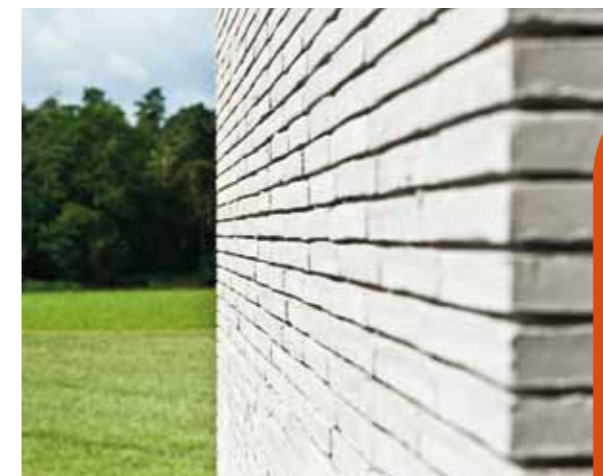
Der langgezogene Vormauerziegel unterstreicht Form und Anordnung der Baukörper. Durch die sehr dünne Lagerfuge bleibt die Verfugung unsichtbar und es entsteht ein spannendes Licht- und Schattenspiel, das für die besondere Anmutung der Klinkerfassade sorgt.
